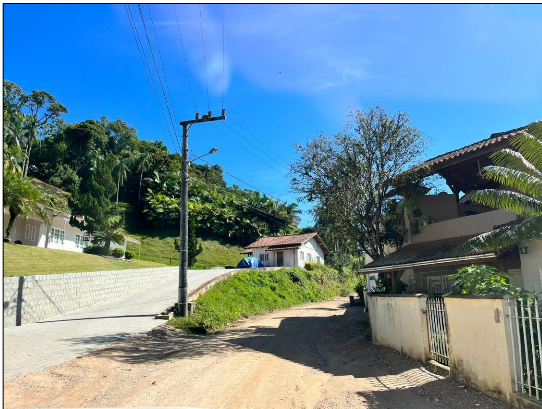
Figura 15 - Trecho da Rua João Gartner (março/2023)
