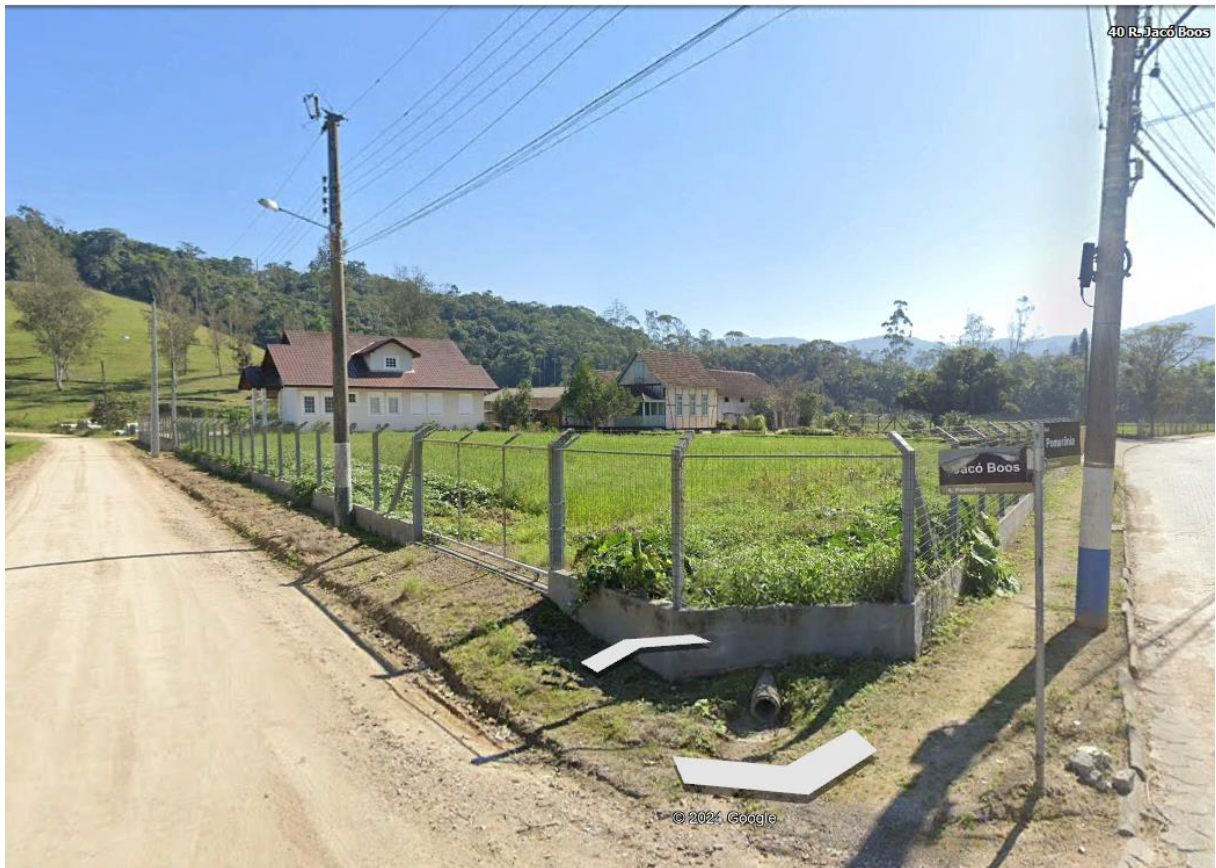
Figura 08: Infraestrutura de energia elétrica disponível na Rua Jacó Boos.
